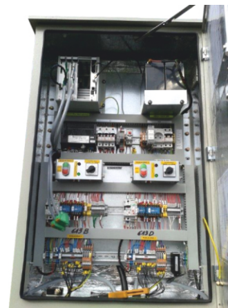
Объектный шкаф SO1/2G/THO с блоком управления SO-52v-21-AUT
