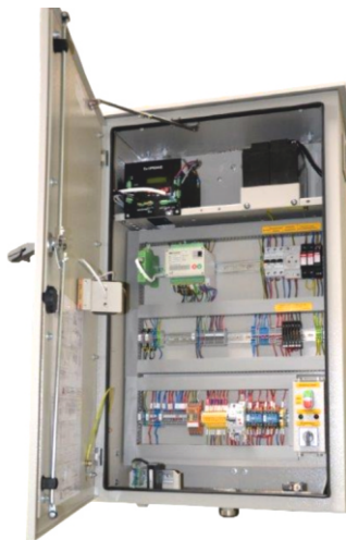
Объектный шкаф SO5G/THO с блоком управления Ex-mBEL_S2
